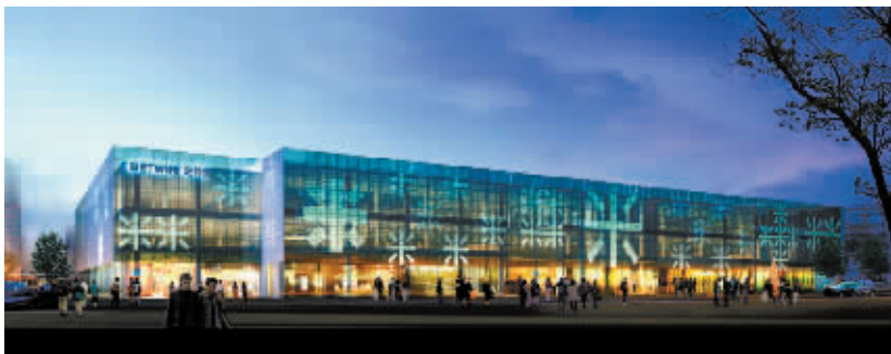
▲ 波特营面向世纪大道的立面,采用丁乙著名的米字图式。这个外立面还可以根据需要变换图式
